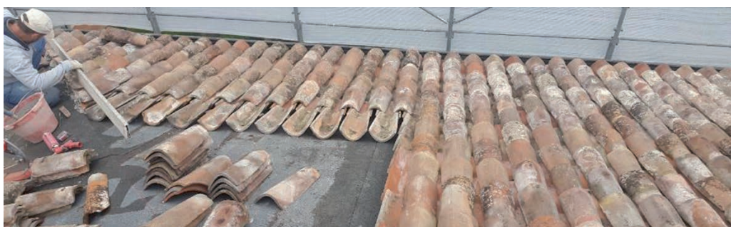
FOTO 3): Ripristino della copertura della sede municipale in viale delle Rimembranze e riqualificazione dell'ufficio portineria e ufficio contratti
