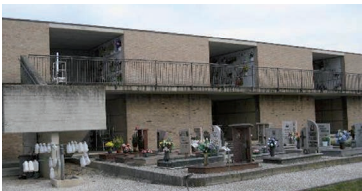
FOTO 1): Realizzazione di nuovo blocco cinerari della capienza di 28 nicchie nel Cimitero della Frazione di Ballò.
